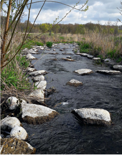
LAV favorisiert die naturnahe Bauweise wie bei dieser Fischtreppe im Teuchelbach bei Güstrow.
