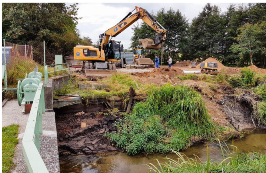
Abrissarbeiten. Die Wasserkraftanlage wurde demontiert. Die Gefahr durch Turbinen für Fische dort gebannt.
