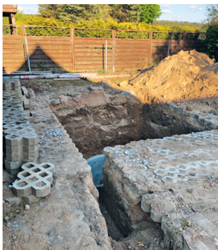
Bis in die Tiefe musste Erde bewegt werden. Umfangreiche Arbeiten, die zwingend nötig waren.
