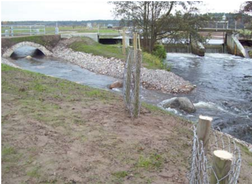
Umgehungsgerinne am Wehr Tewswoods
