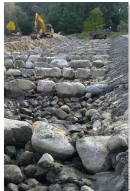
Sohlgleite Brömsenberg kurz vor der Fertigstellung Foto: M.Voigt
