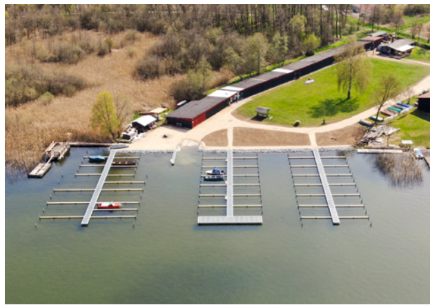
Wie imposant die Steganlage geworden ist, zeigt der Blick aus der Luft. Hier wurden viele gute Ideen bestens umgesetzt.
