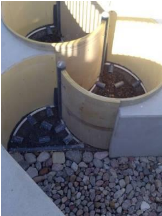
Abbildung 4 Mäanderfischpass am Mühlenteich in Wismar kurz vor der Fertigstellung 2013
