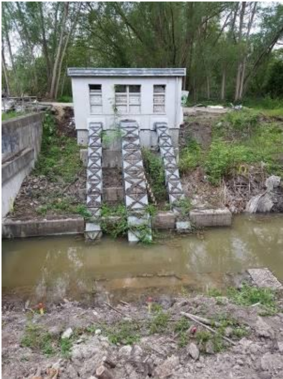
Abbildung 18 Wasserkraftanlage an der alten Papierfabrik
