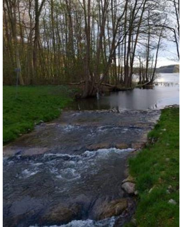
Abbildung 14 Sohlgleite am Lostener See, Fertigstellung 2012
