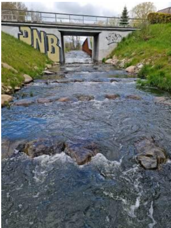
Abbildung 6 Sohlgleite in Grönings, Fertigstellung 2018
