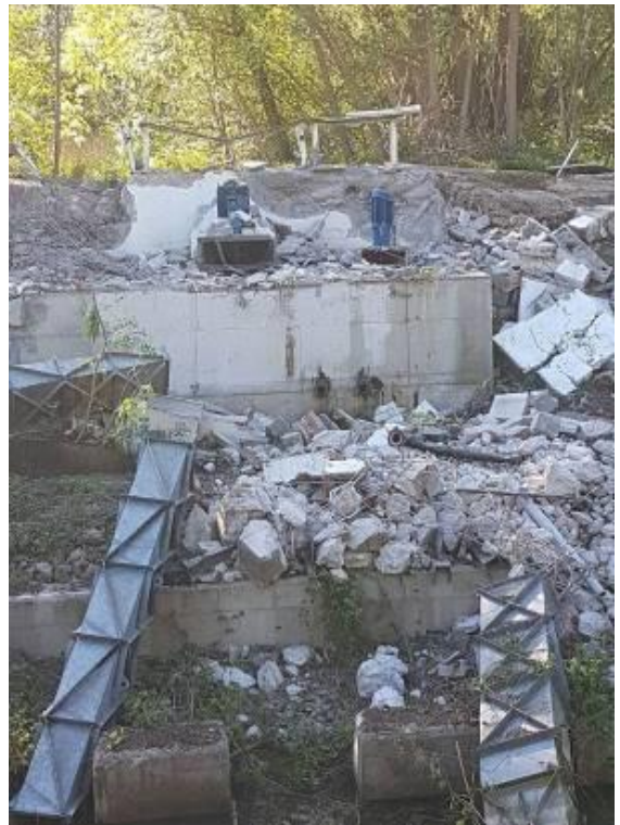
Abbildung 17 Abriss dieser Anlage drei Kaplanturbinen
