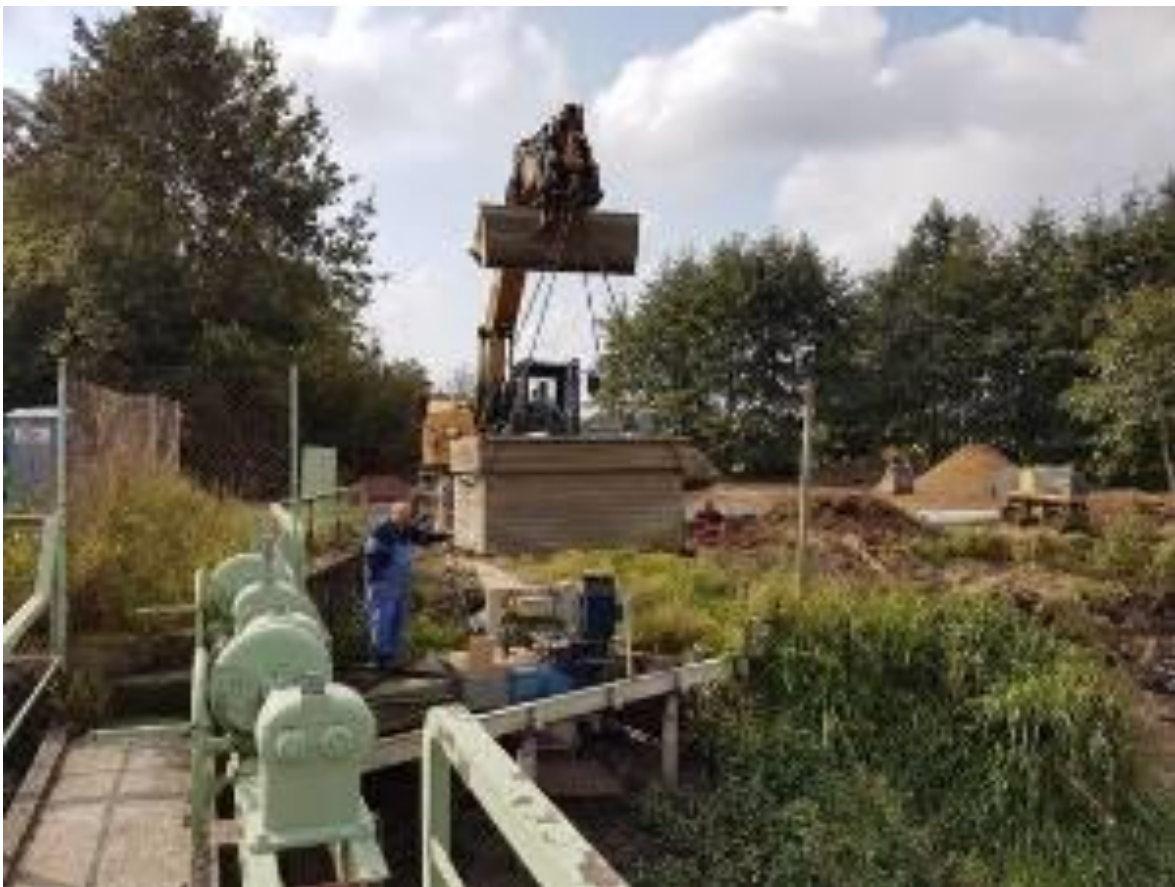
Abbildung 19 Demontage der Wasserkraftanlage einer Rohrheberturbine in Grönings
