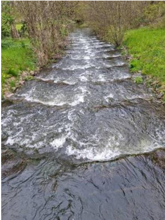
Abbildung 7 Sohlgleite in Steffin, Fertigstellung 2008
