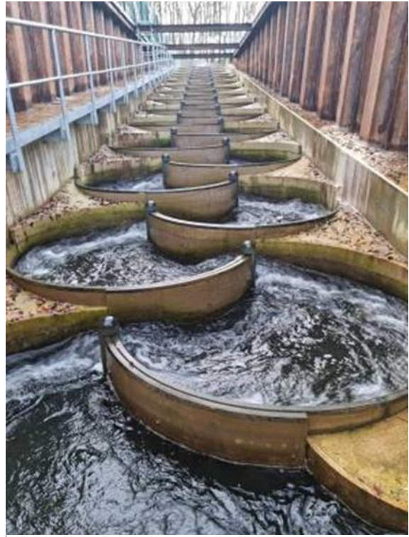
Abbildung 8 Mäanderfischpass oberhalb der A 20, Fertigstellung 2021
