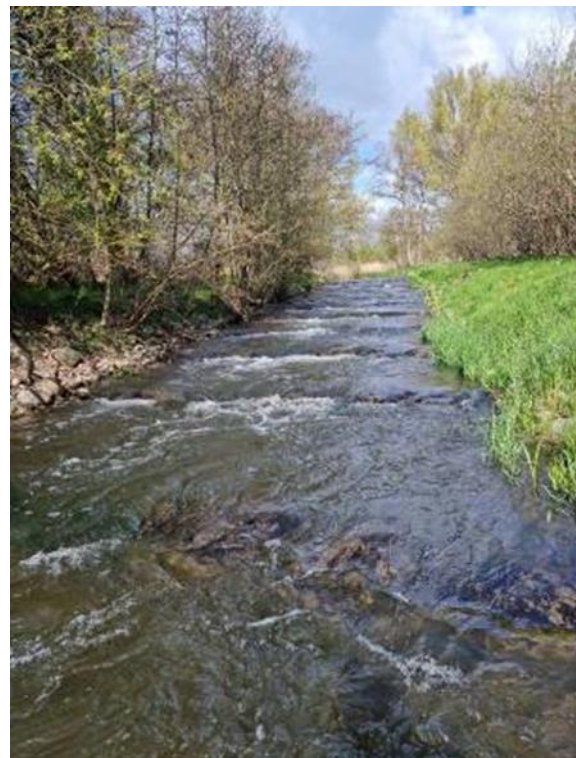
Abbildung 7 Sohlgleite oberhalb Grönings Viereggenhöfer Teich, Fertigstellung 2011
