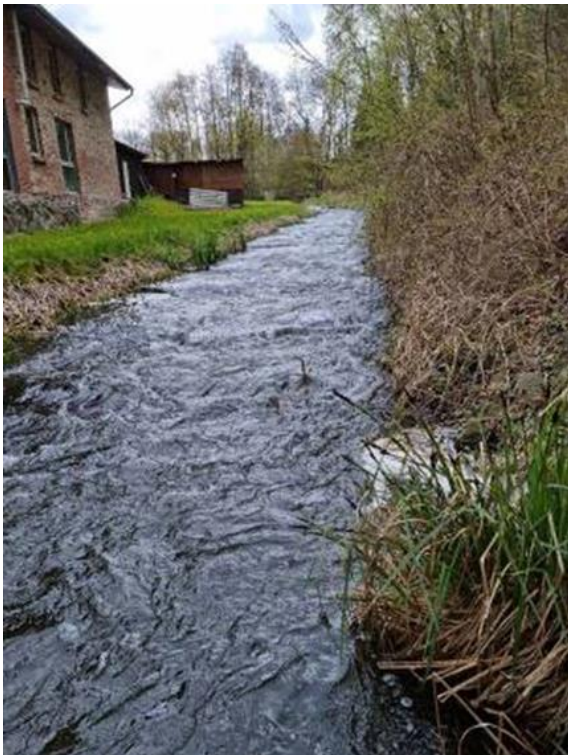
Abbildung 13 . Sohlgleite in Moidentin, Fertigstellung 2010
