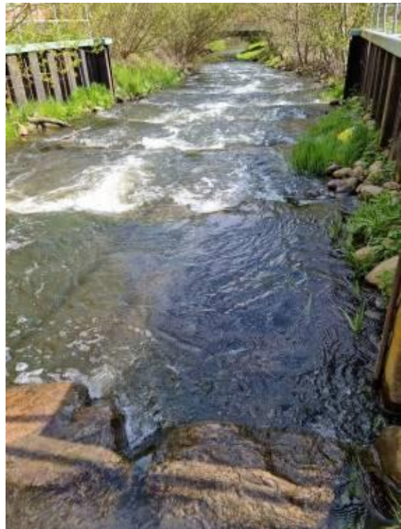
Abbildung 5 Sohlgleite in Kluß, Fertigstellung 2009
